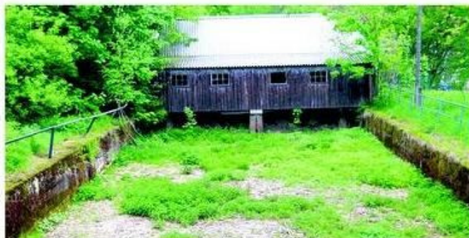
Die alte Wasserkraftanlage auf dem Wollreißerei-Gelände. FOTO: THOMAS FRITZSCH
