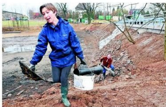
Brückenbaustelle an den Halsbacher Teichen: Ute Straßburg und Tobias Mehnert entmüllten am Sonnabend mit fünf weiteren Helfern Teiche und Uferböschungen. Rechts unterhalb der Brückenfahrbahn befinden sich die Amphibiendurchlässe. FOTO: ECKARDT MILDNER
