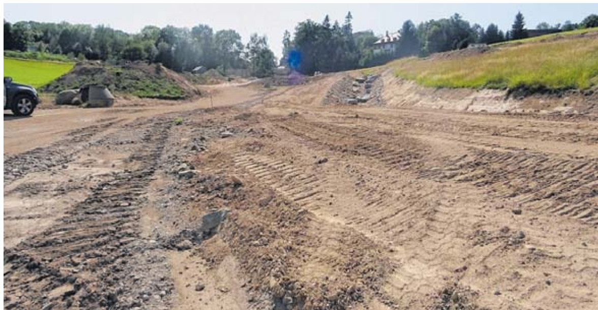
Ein Blick auf die Baustelle: Rechts oben im Hang das künstlich angelegte Bachbett.
